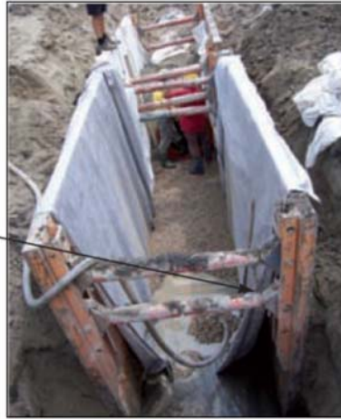
Figura 5 – Scavo a sezione obbligata con casseforme autoaffondanti
