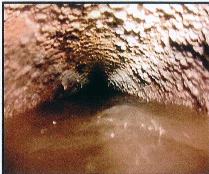
Fig.14 Immagini di rilievo dello stato interno della vecchia condotta consortile Santa Vittoria d'Alba-Alba nei pressi di Loc. Cinzano.
