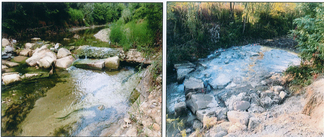
Fig.5-6 Immagini pre e post- intervento della Fognatura comunale di Alba in corrispondenza dell'attraversamento del Torrente Cherasca.
