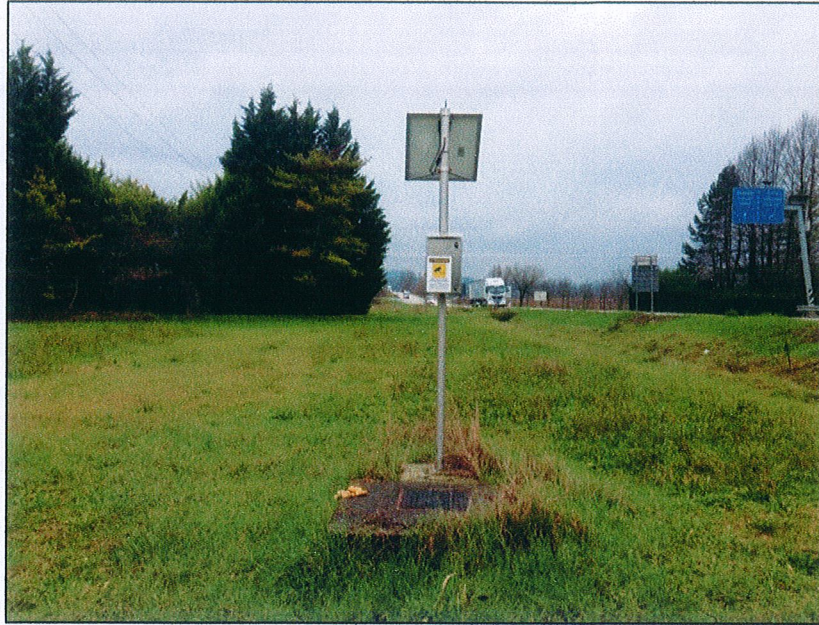
Fig.19 Immagini posizionamento dell'attuale strumentazione di misura di livello (Alba-Loc. Conforso).
