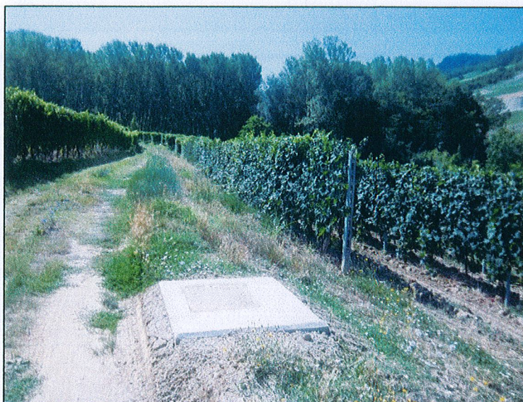
Fig.15 Immagini di sistemazione finale pozzetti (Ramo Serralunga d'Alba)
