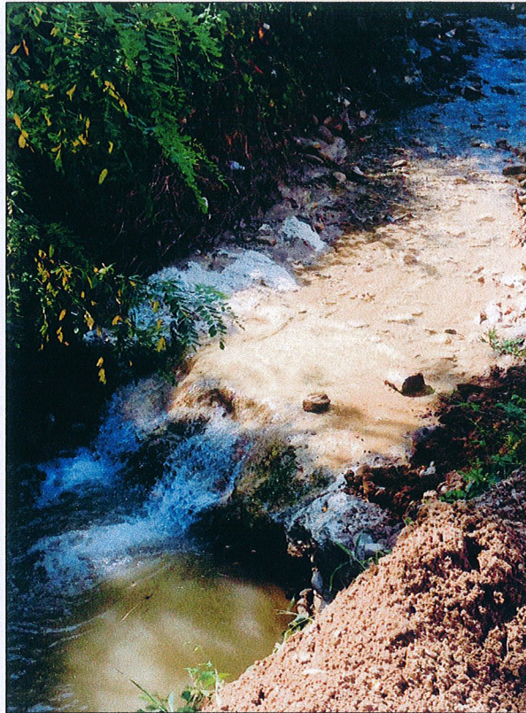
Fig.13 Immagini di rilievo dell'attraversamento fognario consortile (Fognatura Monforte-Alba) Torrente Bussia.
