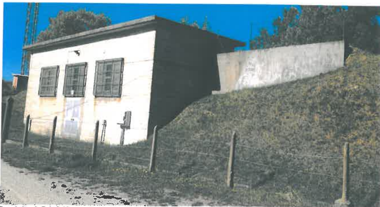
Lequio Berria Bric Schiappa – facciata camera di manovra (vista da est)
