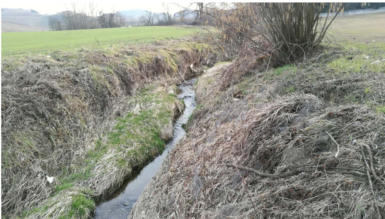
Figura 4 – Alveo del rio Valle Aiello subito a monte dell'area di intervento
