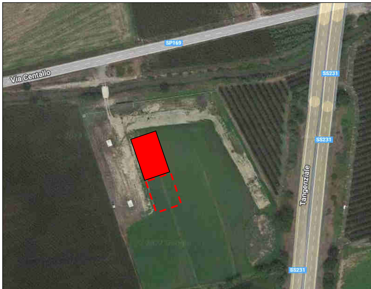
Immagine area disponibile per il sito di San Magno (da www.google.com/maps ), con occupazione fabbricato serbatoio esistente e zona di ampliamento per nuovo serbatoio
