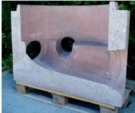
Figura XX – Dettaglio vasca di fondo sagomata
