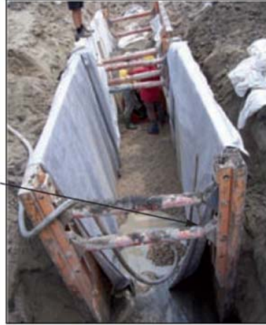
Figura 5 – Scavo a sezione obbligata con casseforme autoaffondanti
