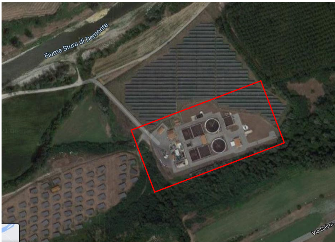
Figura 2 – Inquadramento dell'impianto di depurazione esistente nel comune di Fossano
