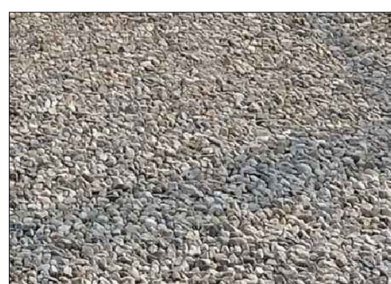
Pavimentazione in misto granulare compattato a rullo
