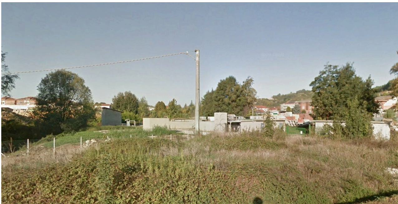
Figura 15 – Vista esterna Impianto di depurazione Canale Cimitero allo stato di fatto
