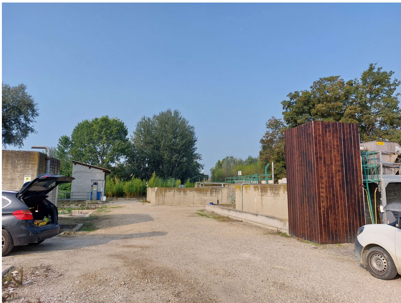
Figura 14 – Impianto di depurazione Canale Cimitero
