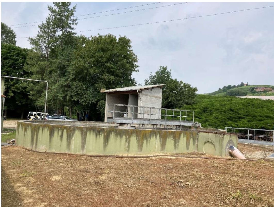
Figura 13 – Impianto di depurazione Canale Valpone: Sedimentatore
