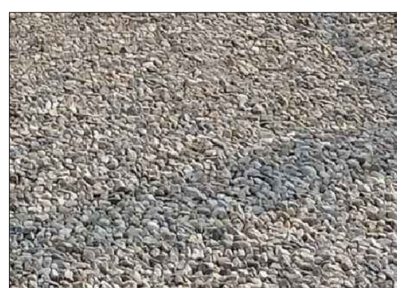
Pavimentazione in misto granulare compattato a rullo
