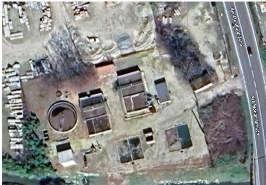
Figura 1 - Impianto di Canale- Loc. Cimitero
