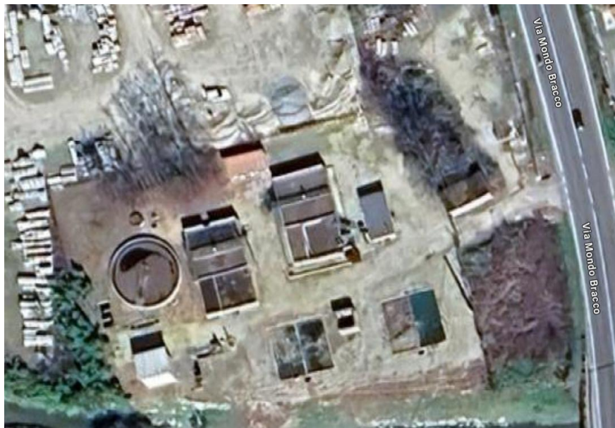
Figura 1 - Impianto di Canale- Loc. Cimitero
