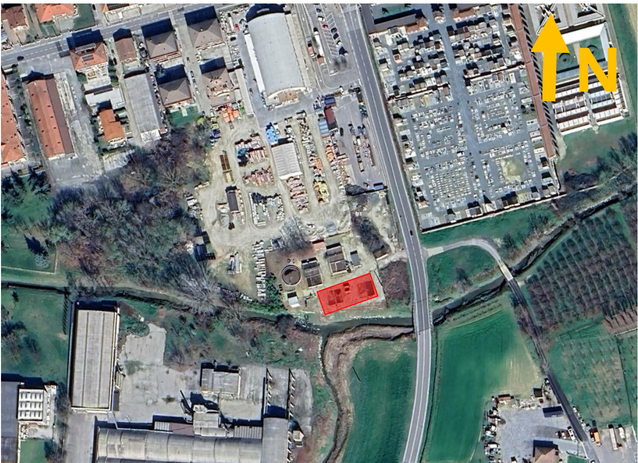
Figura 1 – In rosso l'area in cui sarà realizzato l'impianto fotovoltaico – Depuratore Loc. Cimitero
