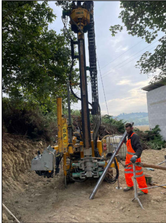
Foto 1: Postazione sondaggio S1.
