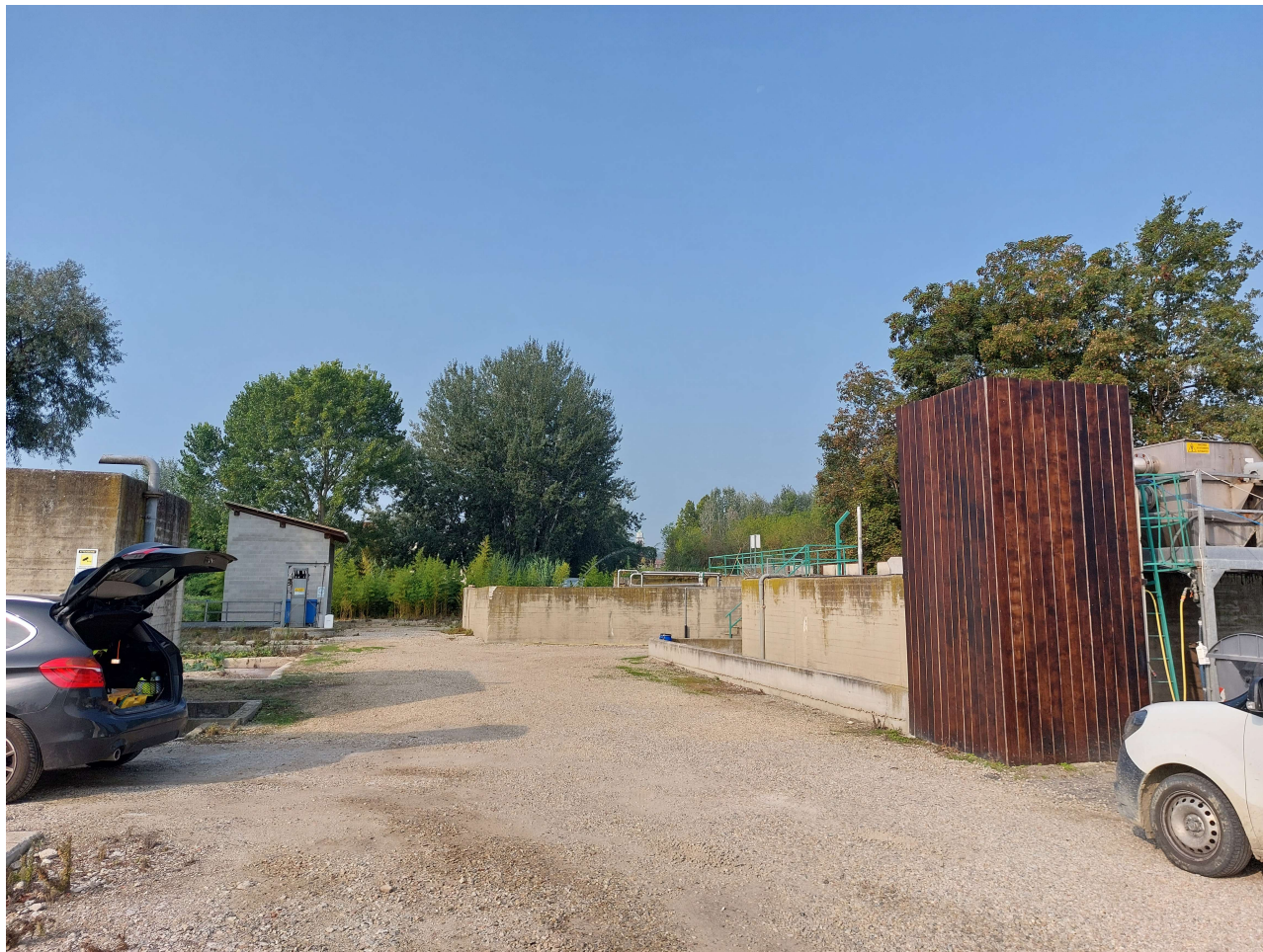
Figura 14 – Impianto di depurazione Canale Cimitero
