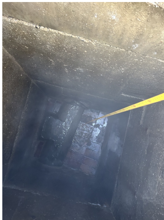
Fig. 14 – rete fognaria nera interferente
