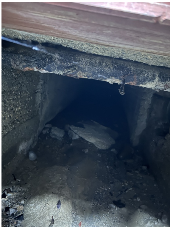
Fig. 13 – rete fognaria bianca interferente
