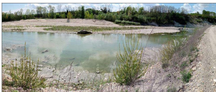
Figura 8: ripresa fotografica dell'alveo del F. Tanaro, in corrispondenza dell'attraversamento in progetto
