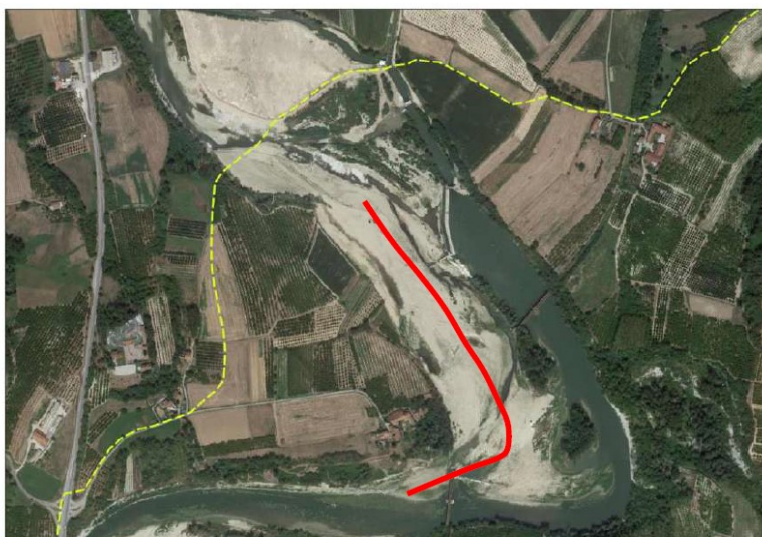
Figura 14: immagine ortofoto dell'area allo stato attuale, con indicazione del tracciato in progetto (in giallo) e dell'arretramento della sponda sinistra (in rosso la posizione precedente)
