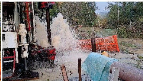
Foto 10: Lo spurgo con aria in pressione
