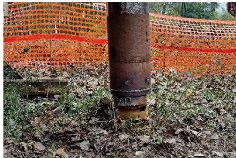
Foto 4: particolare del “martello fondo foro”
