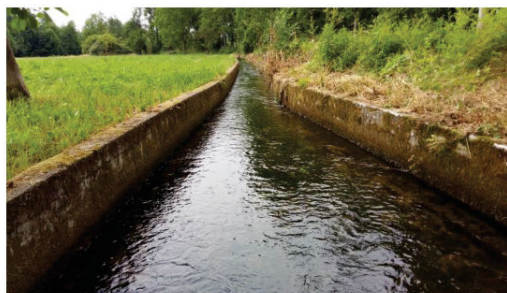
Fig. 7 - Il canale principale che raccoglie la quasi totalità delle acque sorgive
