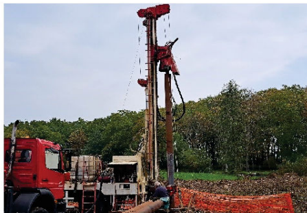
Foto 3: il macchinario per lo scavo del pozzo
