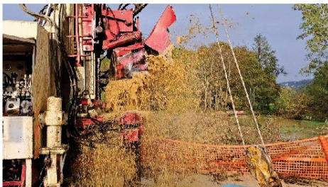
Foto 9: Abbondante presenza d'acqua a 8 m dal p.c.
