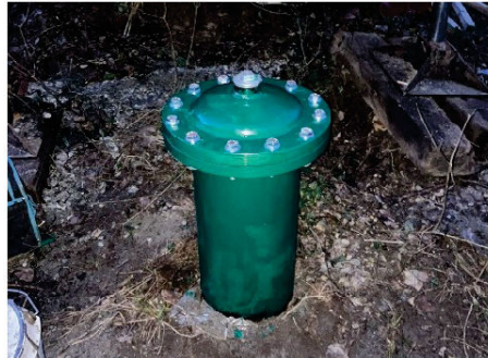
Foto 15: La testa del pozzo sigillata con una chiusura fornita di un foro per le misure dei livelli idrici
