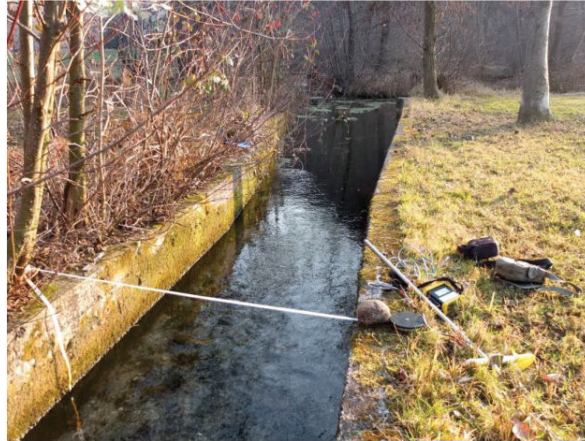
Fig. 13 - Il canale principale dove sono state eseguite le misure della portata idrica di San Matteo
