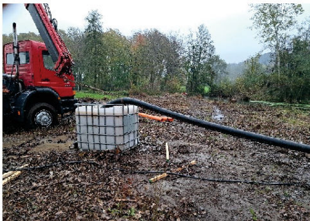
Foto 11: Il contenitore per le misure di portata
