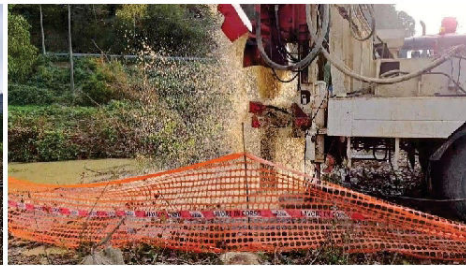
Foto 8: Intercettazione delle ghiaie acquifere
