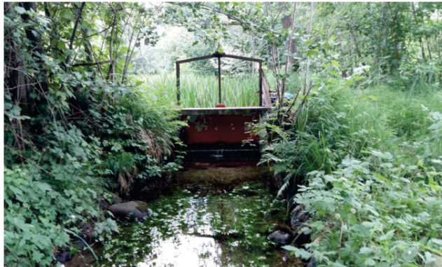
Fig. 5 - La paratia sul bacino idrico di un canale secondario
