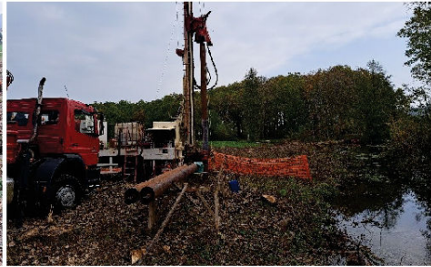
Foto 2: la zona scelta per la realizzazione del pozzo
