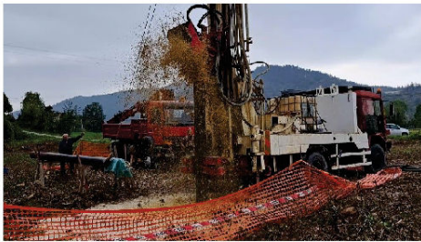
Foto 7: Intercettazione delle prime zone acquifere
