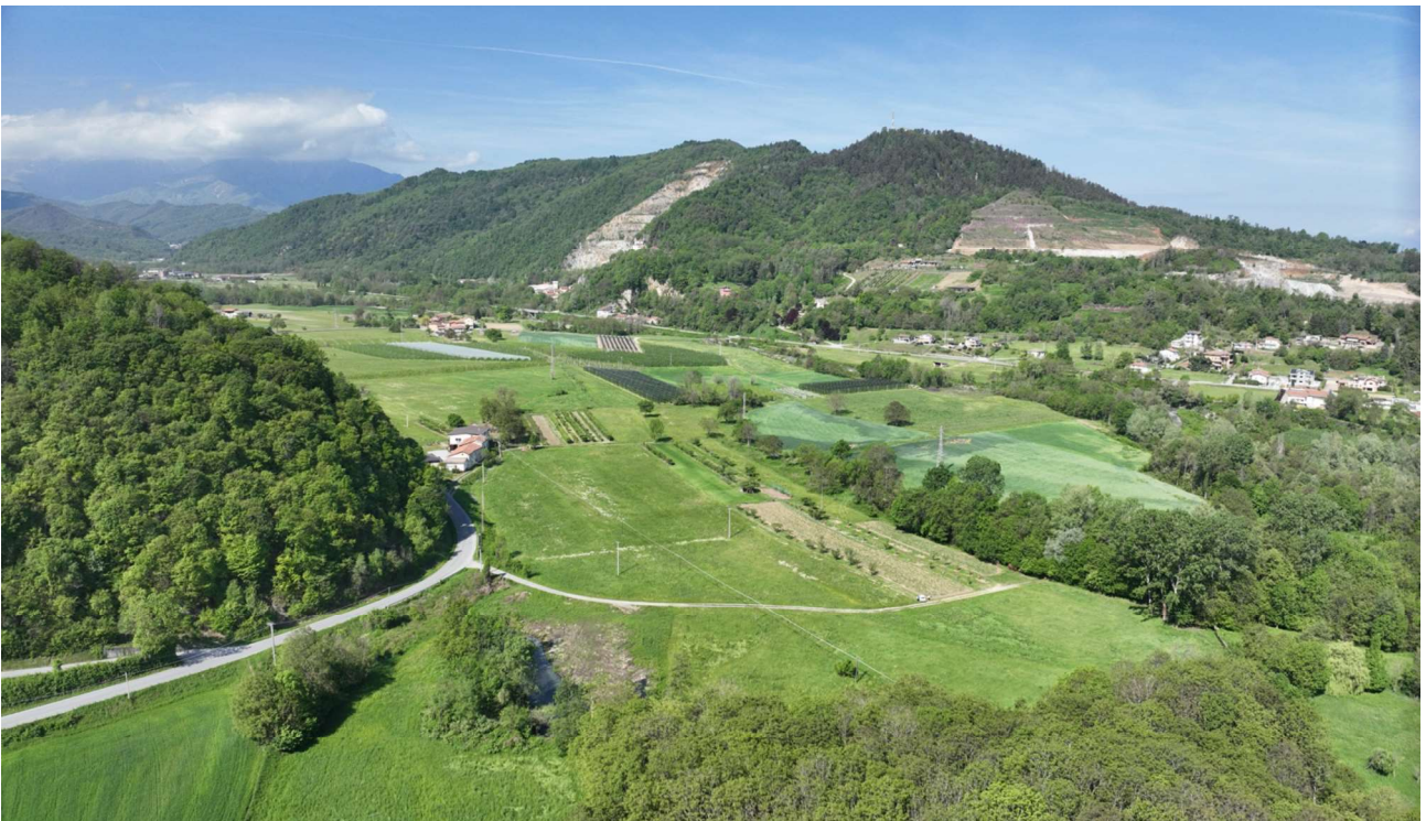
Piana valliva del Torrente Ellero in corrispondenza dell'area di realizzazione dell'intervento
