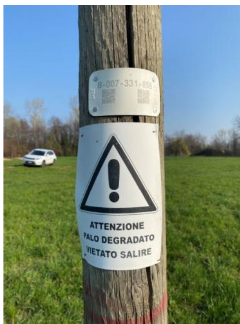
Foto 10, 11 – area di cantiere – particolari del palo Telecom da spostare
