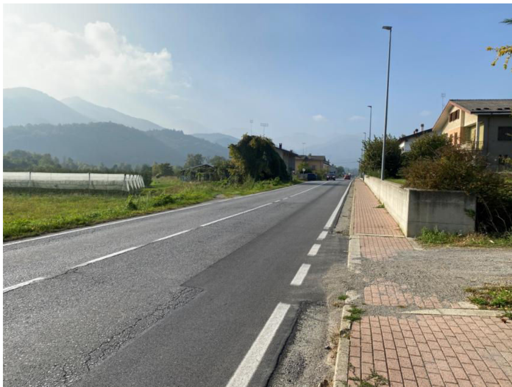
Foto 12, 13 – Nodi A e B – viste da S.P. N. 5 (Via Roccaforte a Villanova Mondovì) Nel nodo A, sul presunto sedime della tubazione dell'Acquedotto, è visibile il recente ripristino della pavimentazione (probabile posa di cavi per fibra ottica interferenti con l'acquedotto)
