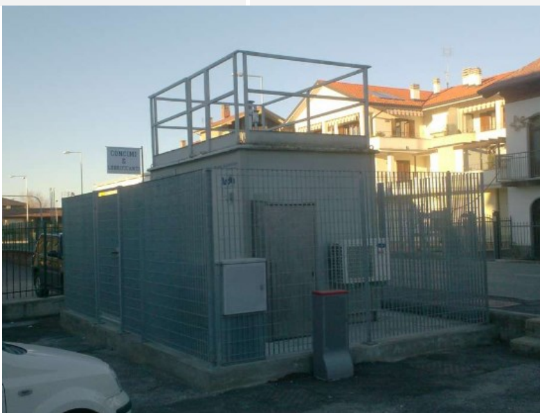
Figura 4.6 - Stazione di Mondovì - Aragno
