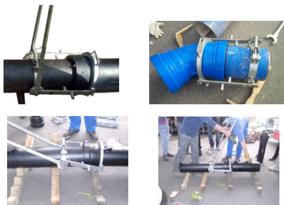
Figura 24 - Fasi di "imbicchieramento delle tubazioni"
