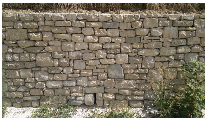
Figura 25 - Finitura tipo rivestimento muri cabina di manovra
