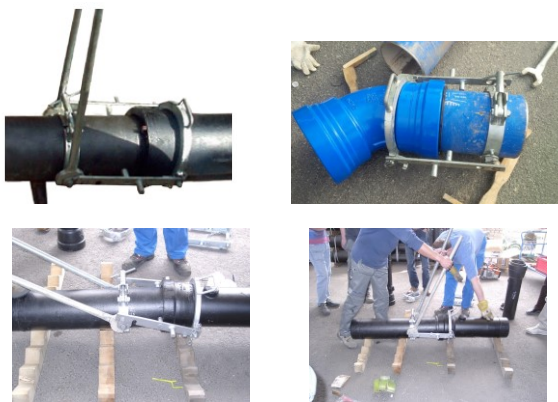
Figura 13 - Fasi di "imbicchieramento" delle tubazioni
