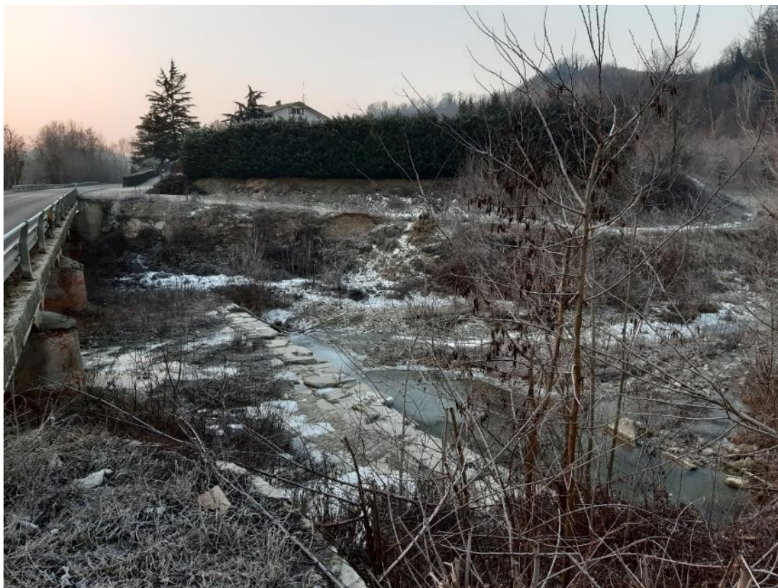
Figura 76 - Punto di presa n. 23 – Monchiero – torrente Rea – ponte SP661
