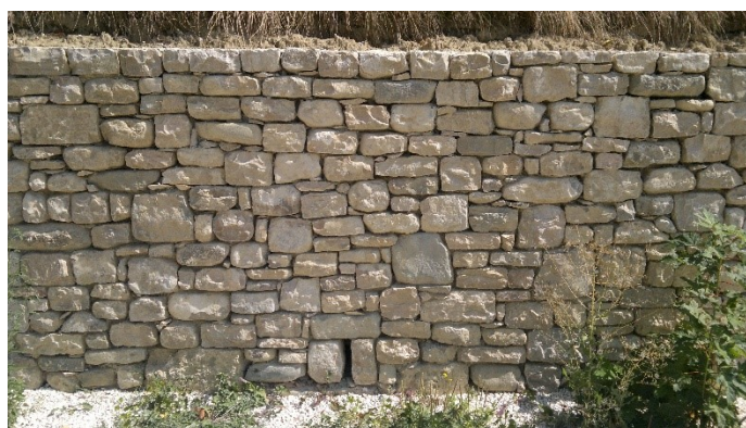
Figura 52 - Finitura tipo rivestimento muri cabina di manovra
