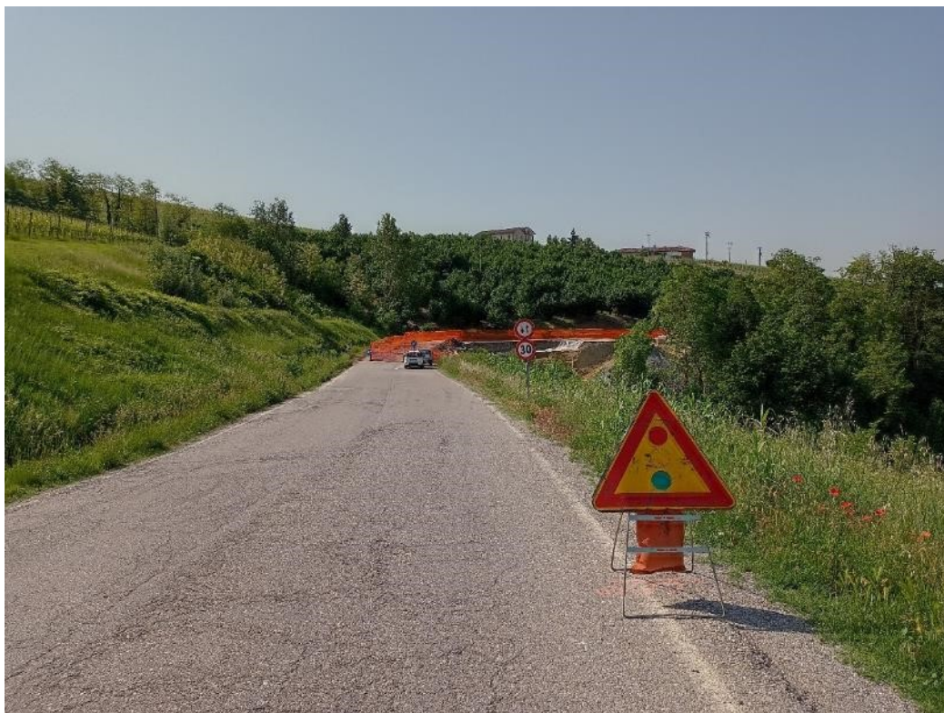
Figura 86 - Punto di presa n. 33 – Monforte d'Alba – località Panirole – SP163
