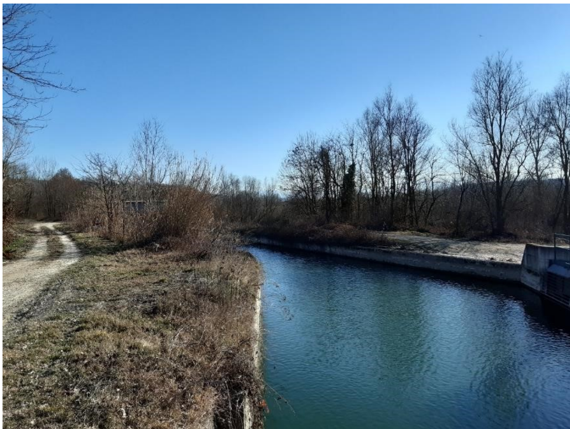
Figura 70 - Punto di presa n. 17 – Monchiero – località Oltre Rea – canale centrale idroelettrica
