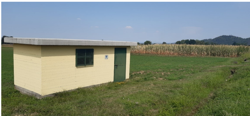
Figura 48 – Cabina di manovra - tipo 1
