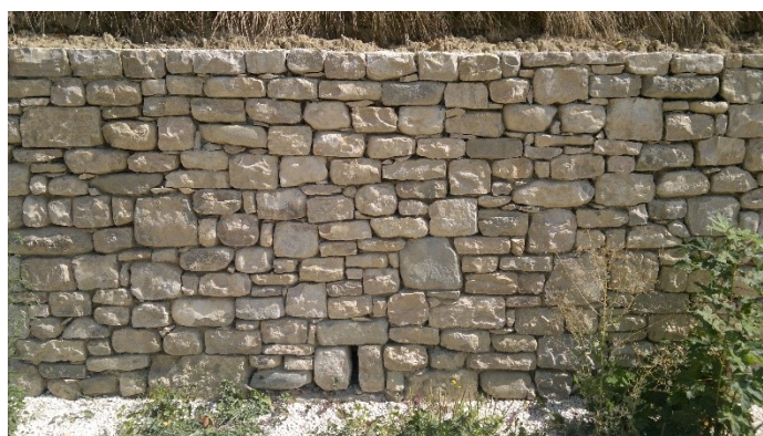
Figura 5 - Finitura tipo rivestimento muri cabina di manovra
