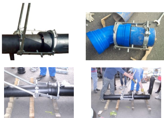
Figura 4 - Fasi di "imbicchieramento" delle tubazioni
