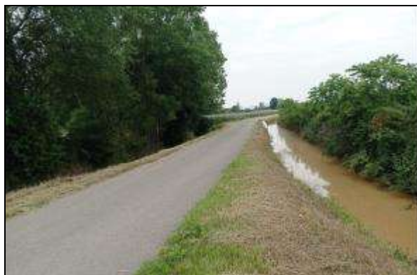
Figura 31: canale irriguo a scorrimento in esercizio a piene sponde presso località Castelletto di Piozzo
