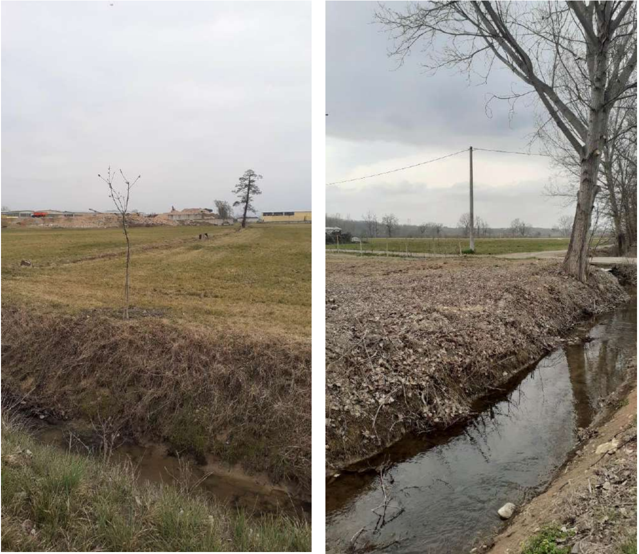
Figura 6: riprese fotografiche della rete idrografica che solca l'altopiano in cui si sviluppa il primo tratto del tracciato in progetto
