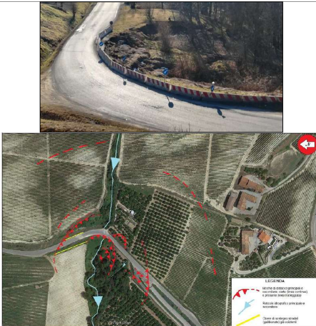
Figura 38: vista del dissesto lungo la S.P. 163, a valle della sede stradale (Fonte: Provincia di Cuneo, Relazione geologica di progetto) e cartografia geomorfologica interpretativa.
