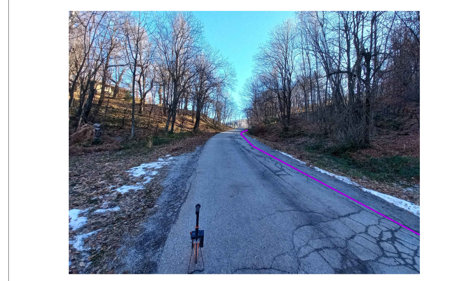
Foto 4 - Percorrenza tratto dal km 5+750 al km 5+968
