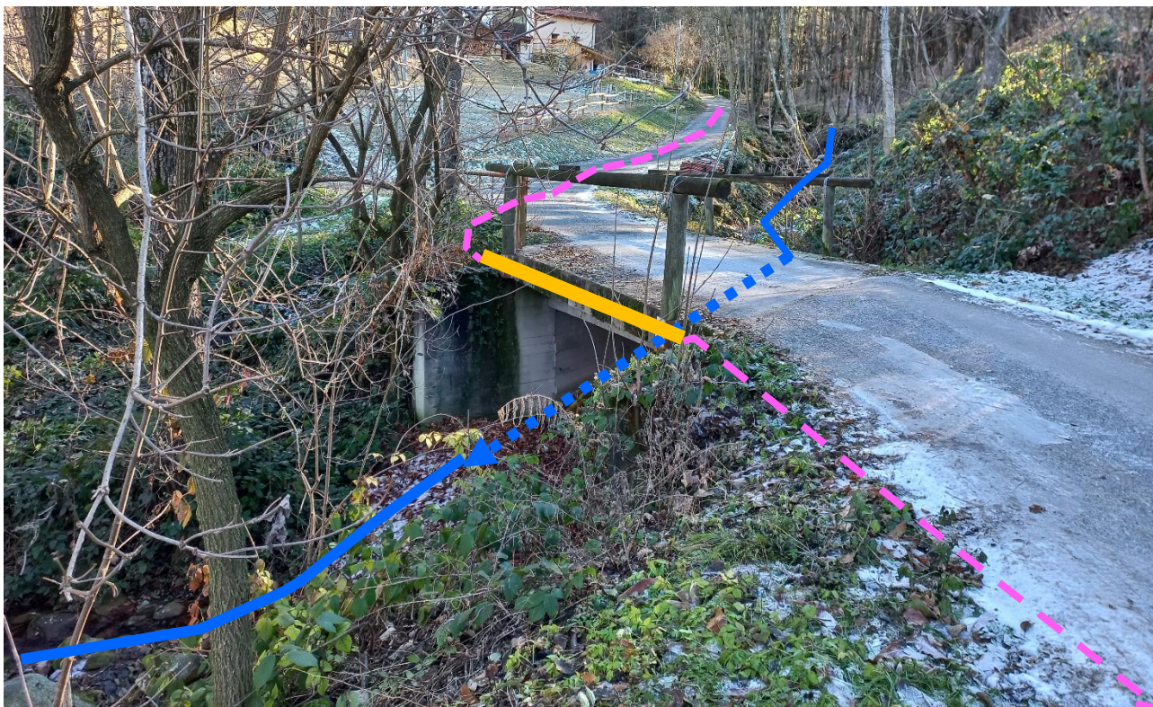
Figura 5 - Rio delle Fornaci - Vista da valle verso monte
