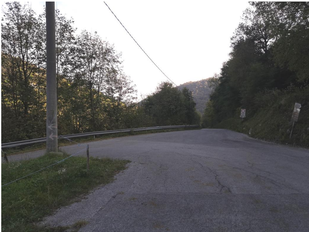
Fotografia 2 Via Norea-Prabertello – Sulla sinistra la linea BT aerea su pali esistenti dove si prevede l'allaccio della cabina di consegna con un cavo BT interrato
