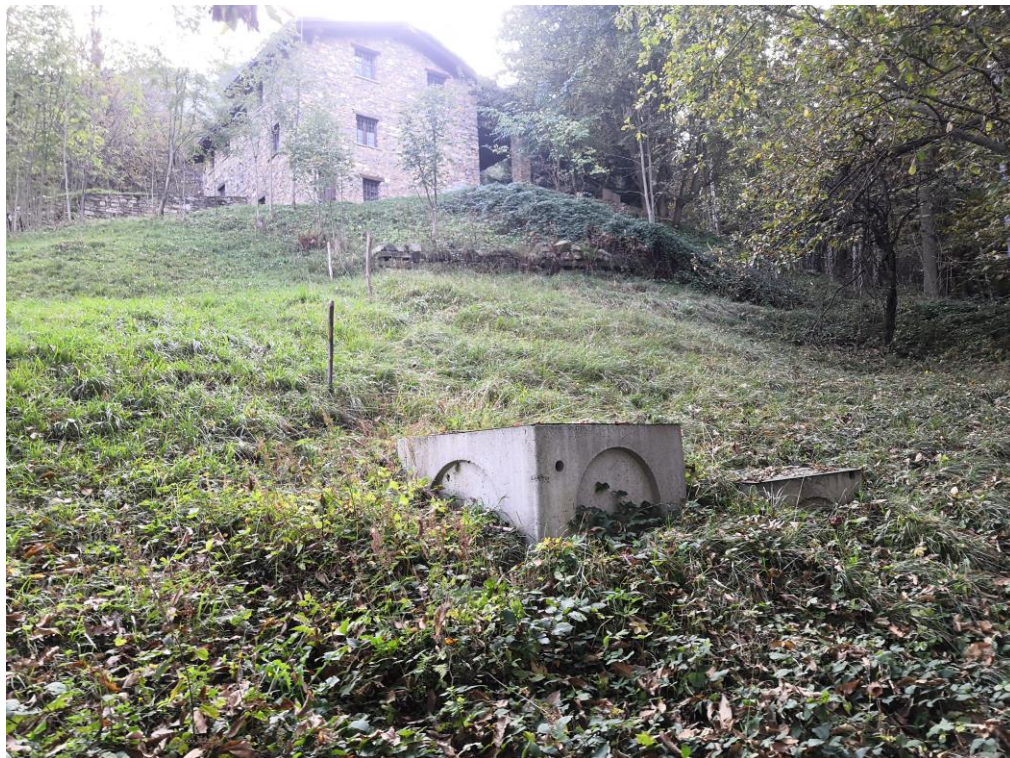
Fotografia 6 Vista del Serbatoio interrato situato poco sopra la strada vicinale Colletto
