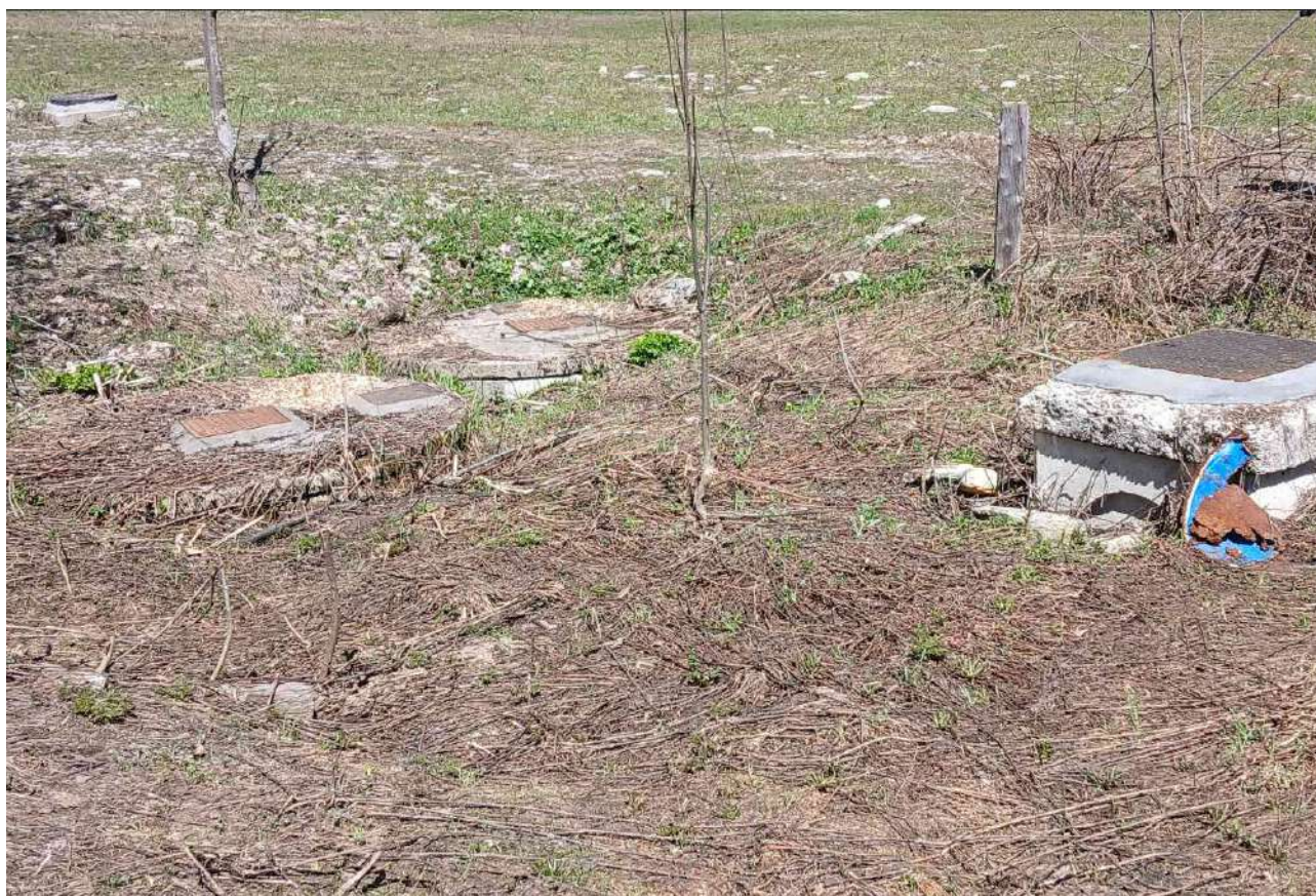
Foto 9 – Vista delle vasche in ampliamento del vecchio depuratore da dismettere.
