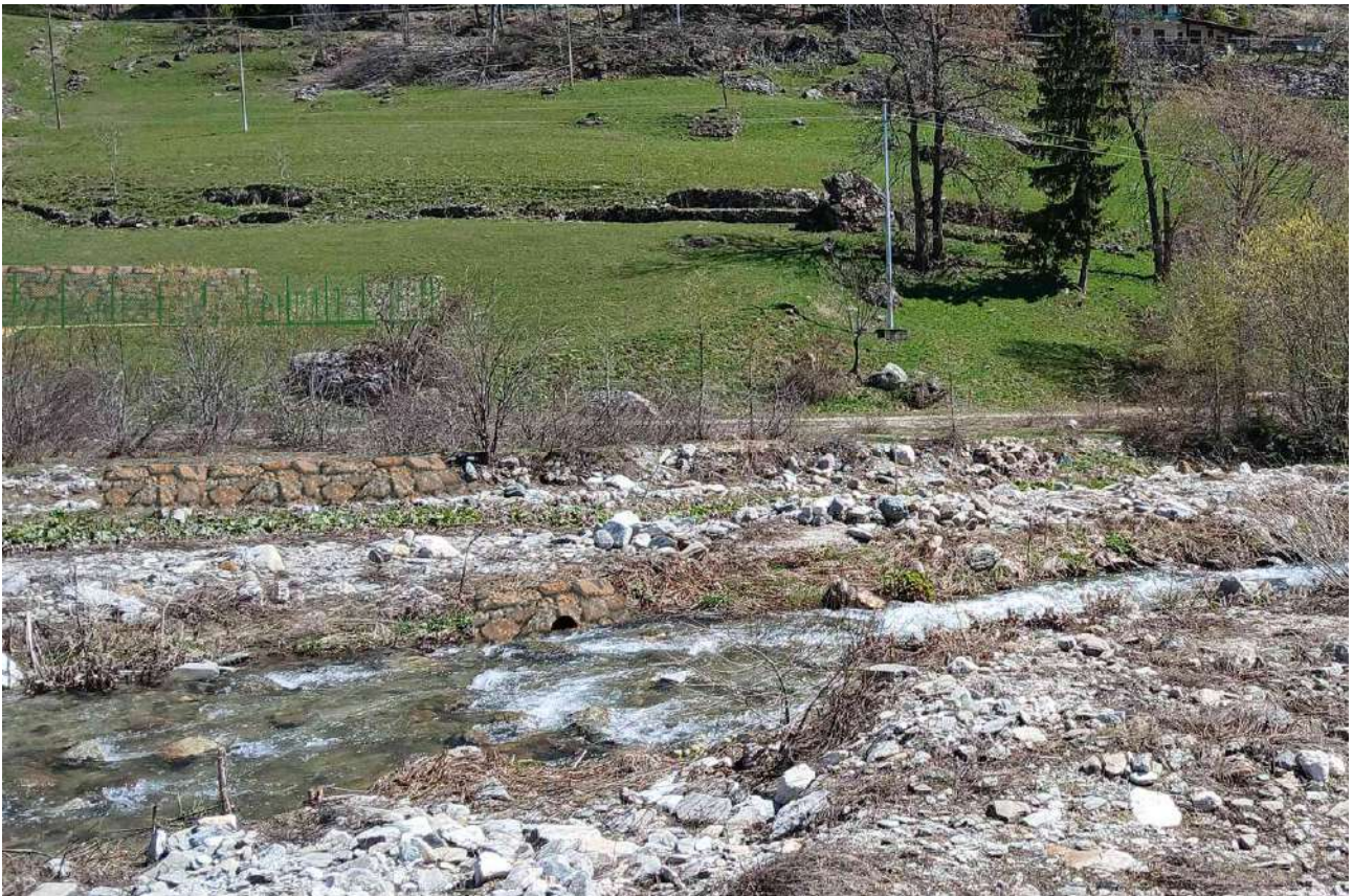
Foto 11 – Fotoinserimento della scogliera di sponda e del nuovo punto di scarico.
