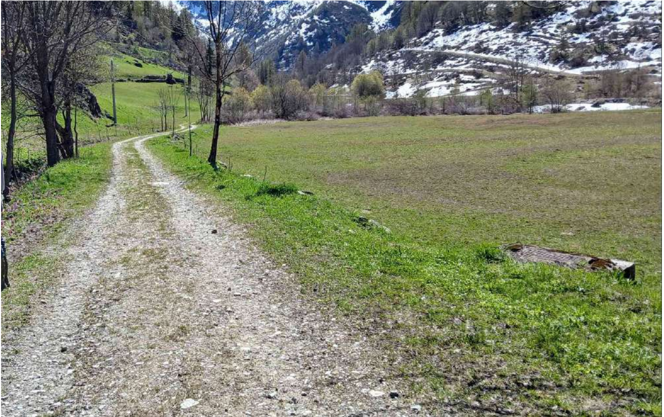
Foto 2 – Pozzetto a lato della pista sterrata da cui partirà la condotta diretta al nuovo depuratore.
