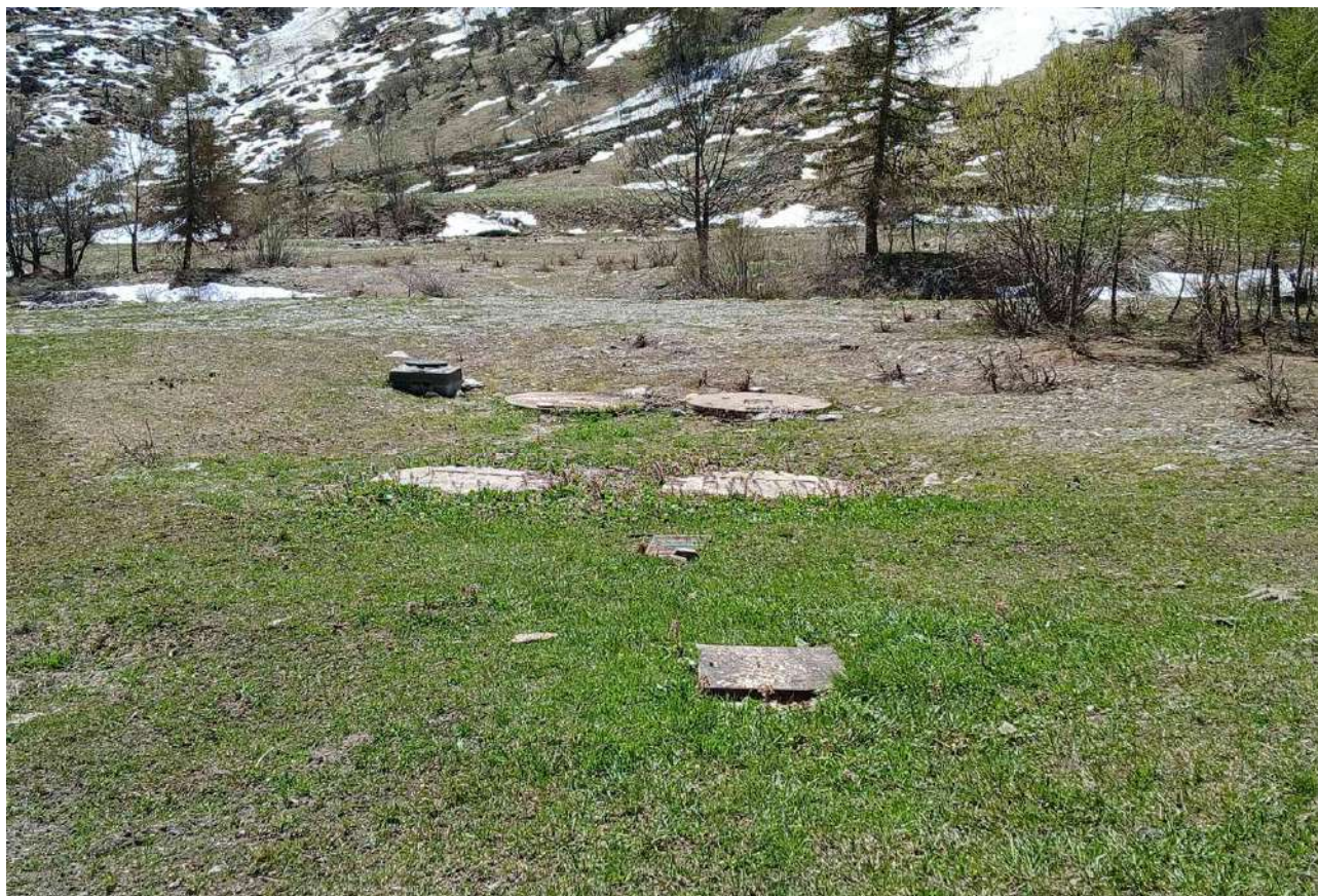
Foto 8 – Vista delle vasche del vecchio depuratore da dismettere.
