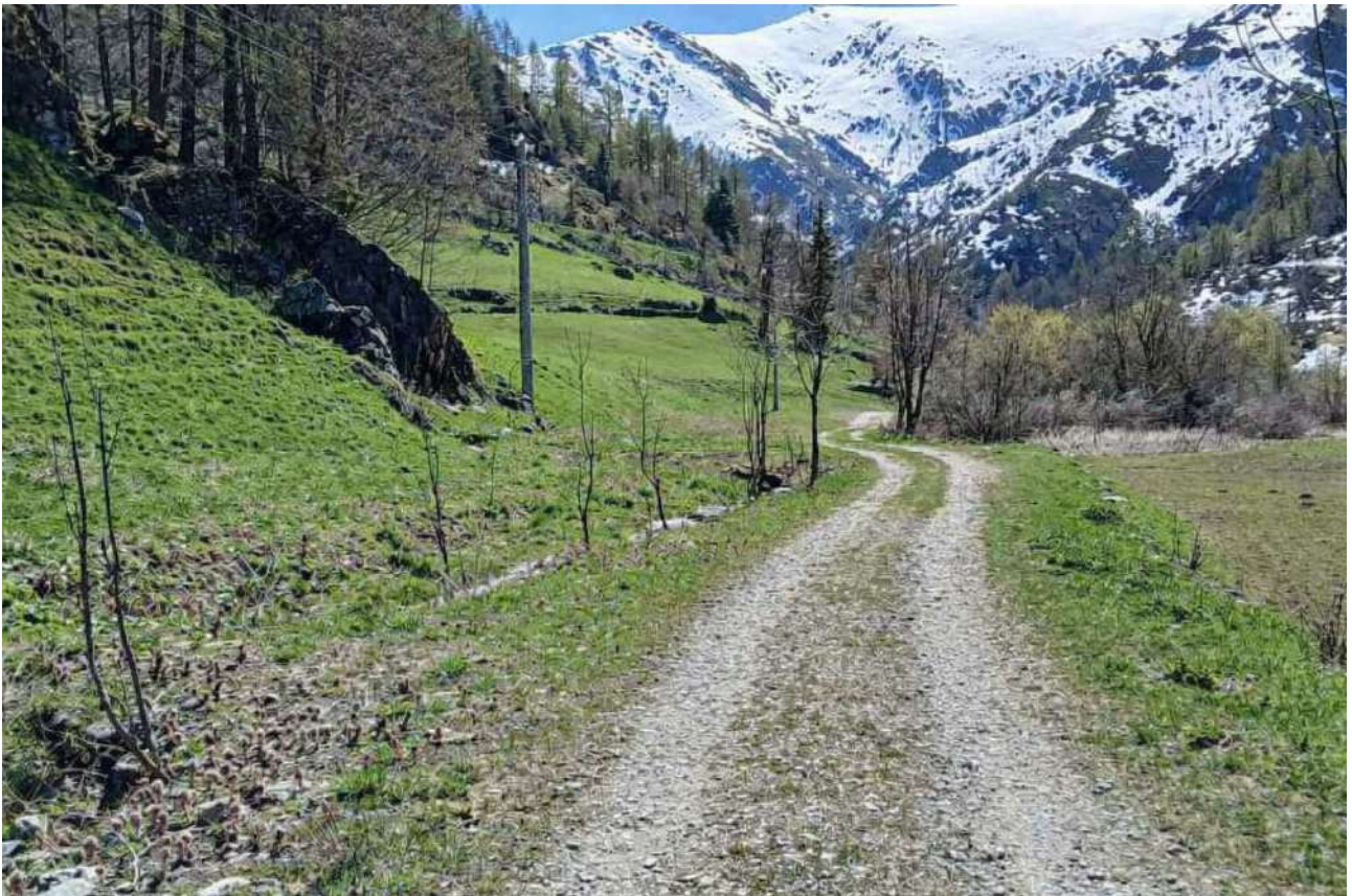
Foto 3 – Tratto di pista sterrata lungo cui è prevista la posa della condotta a monte dell'attraversamento del fosso esistente.
