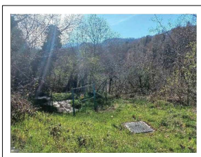
VISTA DELL'AREA OGGETTO DI INTERVENTO
